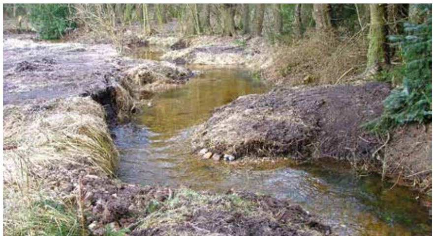
Der ehemalige Sohlabsturz ist im Mühlenbach nicht mehr zu erkennen. Durch den Einbau von Kies wurden der Gewässerverlauf und die Sohle naturnah entwickelt.
