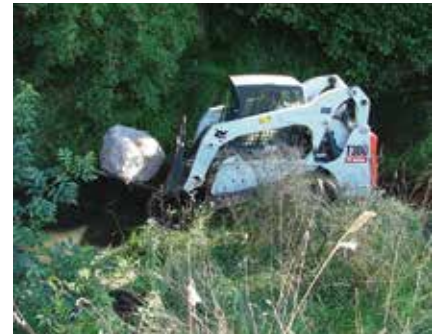
Unter der Ohre-Brücke wurde aus großen Felssteinen eine Berme gebaut.
