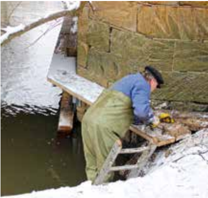
Beim Anbringen der Laufbretter war viel Handarbeit erforderlich.
