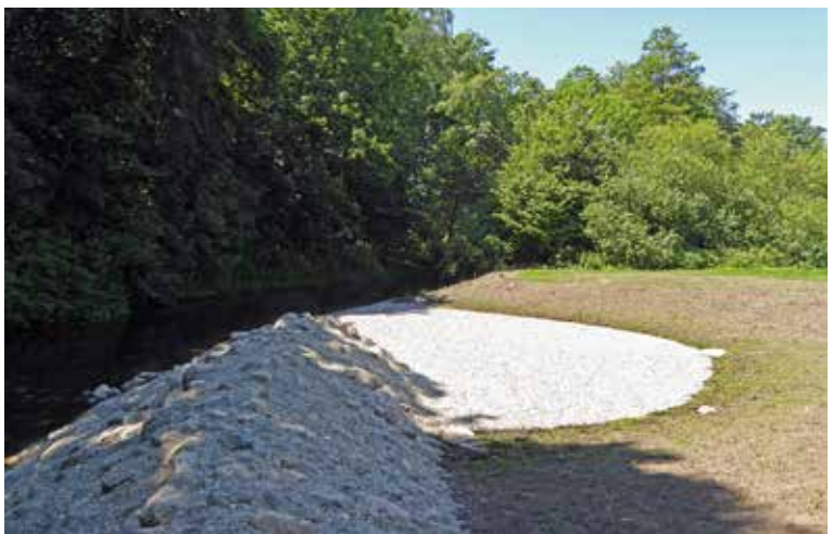
Ein naturnaher Sandfang wurde an der Alster am Gleithang angelegt.
