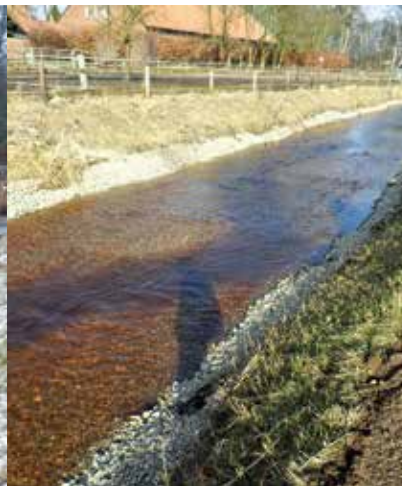
In der neu angelegten Sohlgleite erkennt man die geschlängelte Niedrigwasserrinne.
