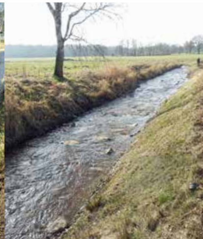
Durch Einbau von Kies und Störsteinen wird die sandige Sohlstruktur verbessert.
