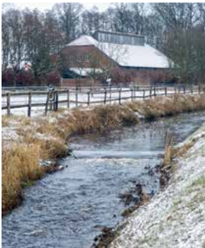
Einer von drei Sohlabstürzen im Gohbach bei Kükenmoor vor dem Umbau.
