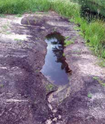
Juni 2017: Uferabflachung mit „Lunke“ an der Ohre bei Gladdenstedt
