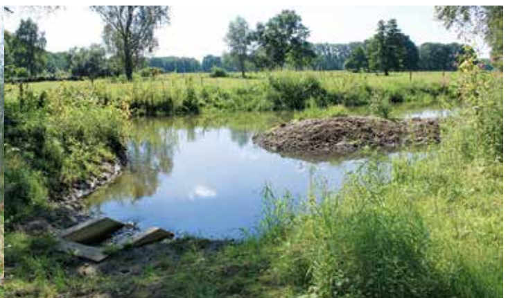
Das neue Einlaufbauwerk und der Schutzdamm mit Blick auf die Fuhse.
