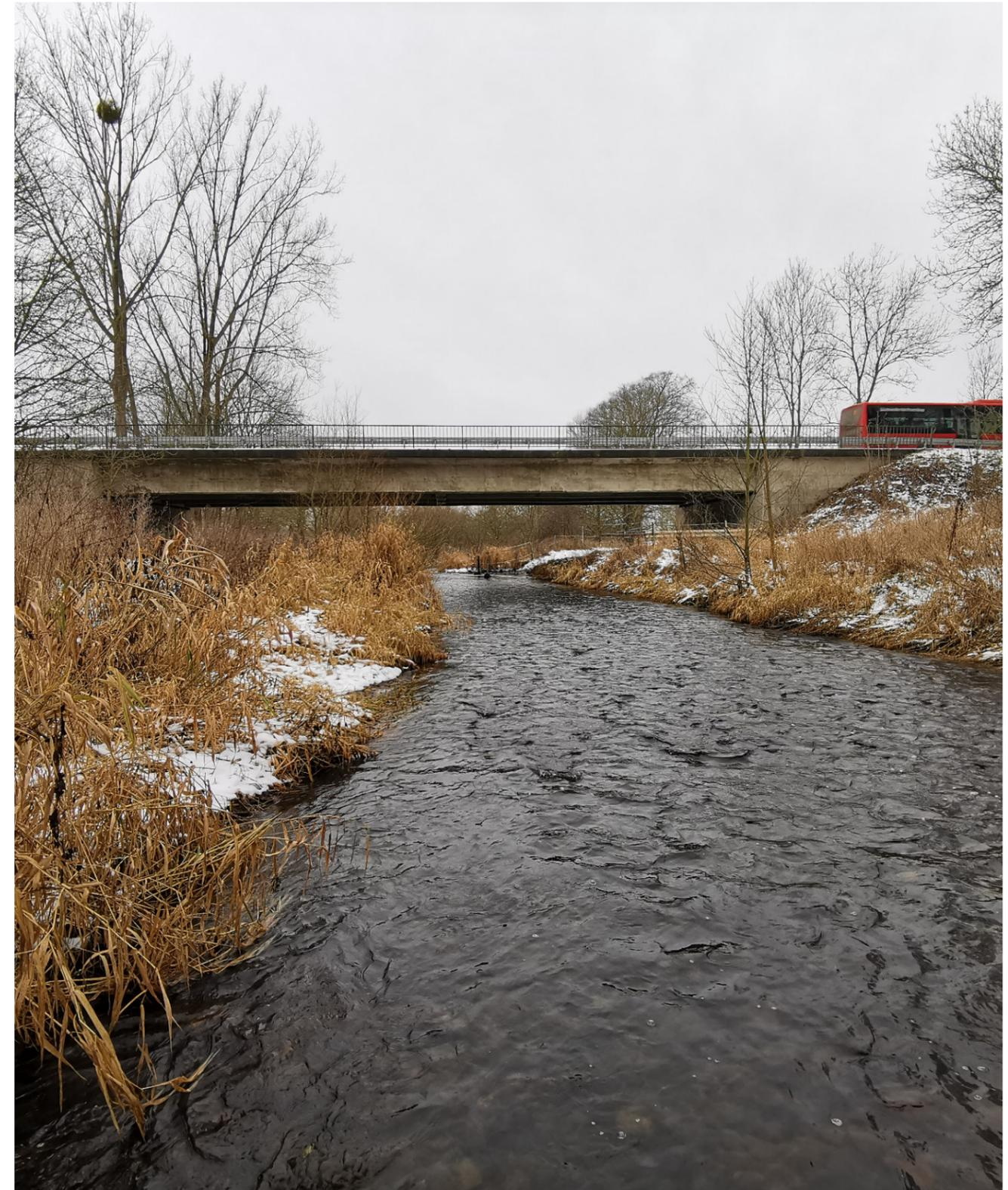
Abb. 25: Positivbeispiel einer Brücke mit beidseitiger Berme
