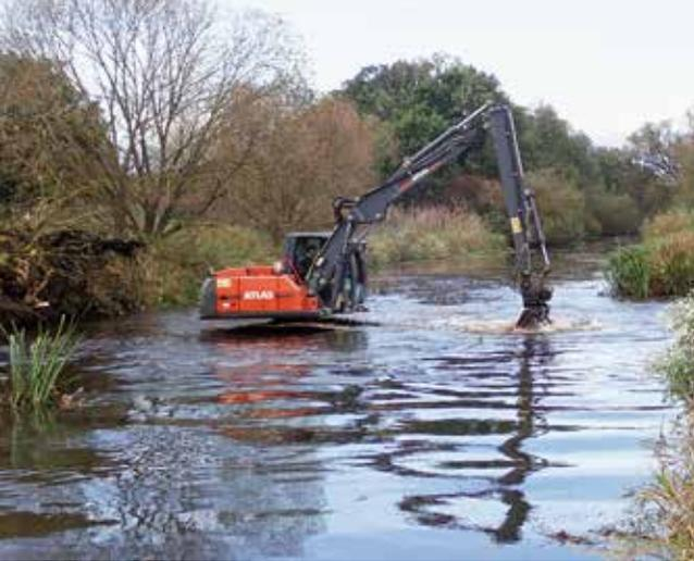
*Zum Einbau der Kiesbänke musste der Bagger in die Aller fahren.*
